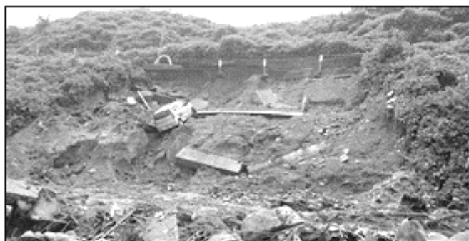
資料6 大雨による被害
